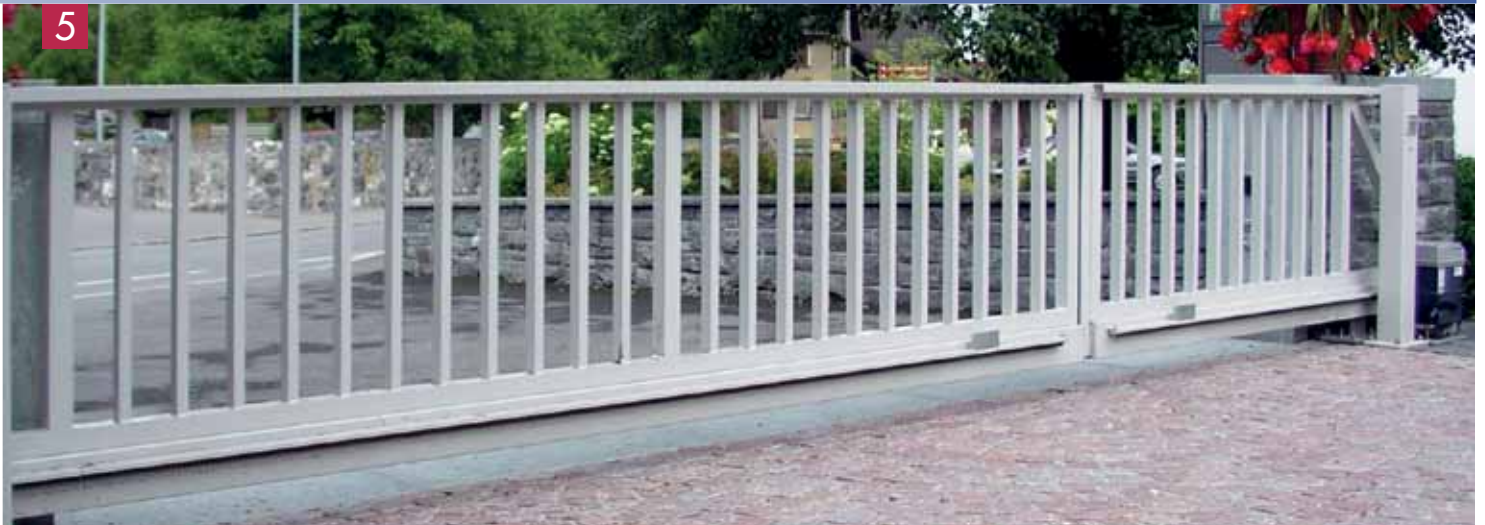
STAKETEN-SCHIEBETORANLAGE asymmetrisch gegenlaufend, Innenansicht
